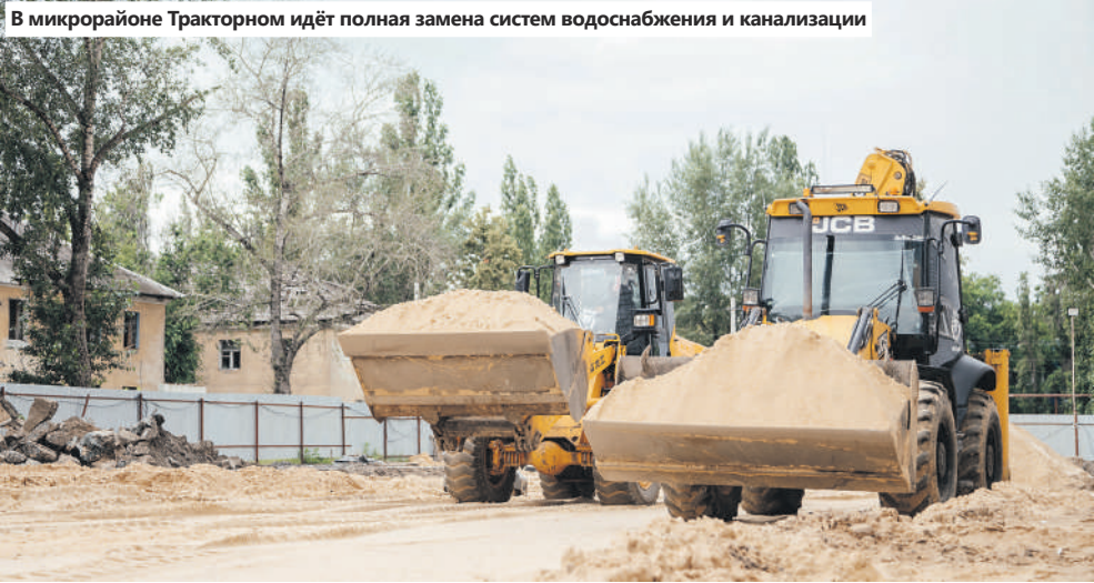
В микрорайоне Тракторном идёт полная замена систем водоснабжения и канализации
